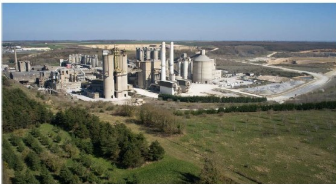
Figure n°2 : Photos de la cimenterie actuelle (source : Dossier n°1, pages 25 et 26)
